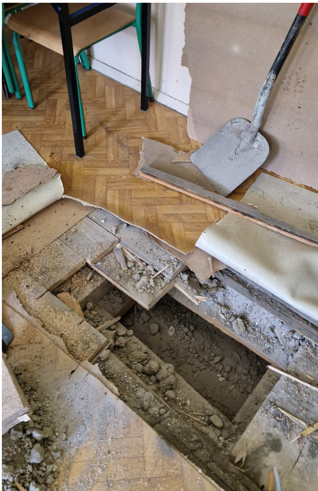
Foto 8. Widok odkrywki konstrukcji stropu nad parterem.
