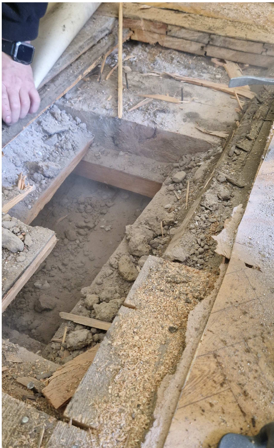
Foto 4. Odkrywka belek drewnianych nośnych stropu nad parterem.
