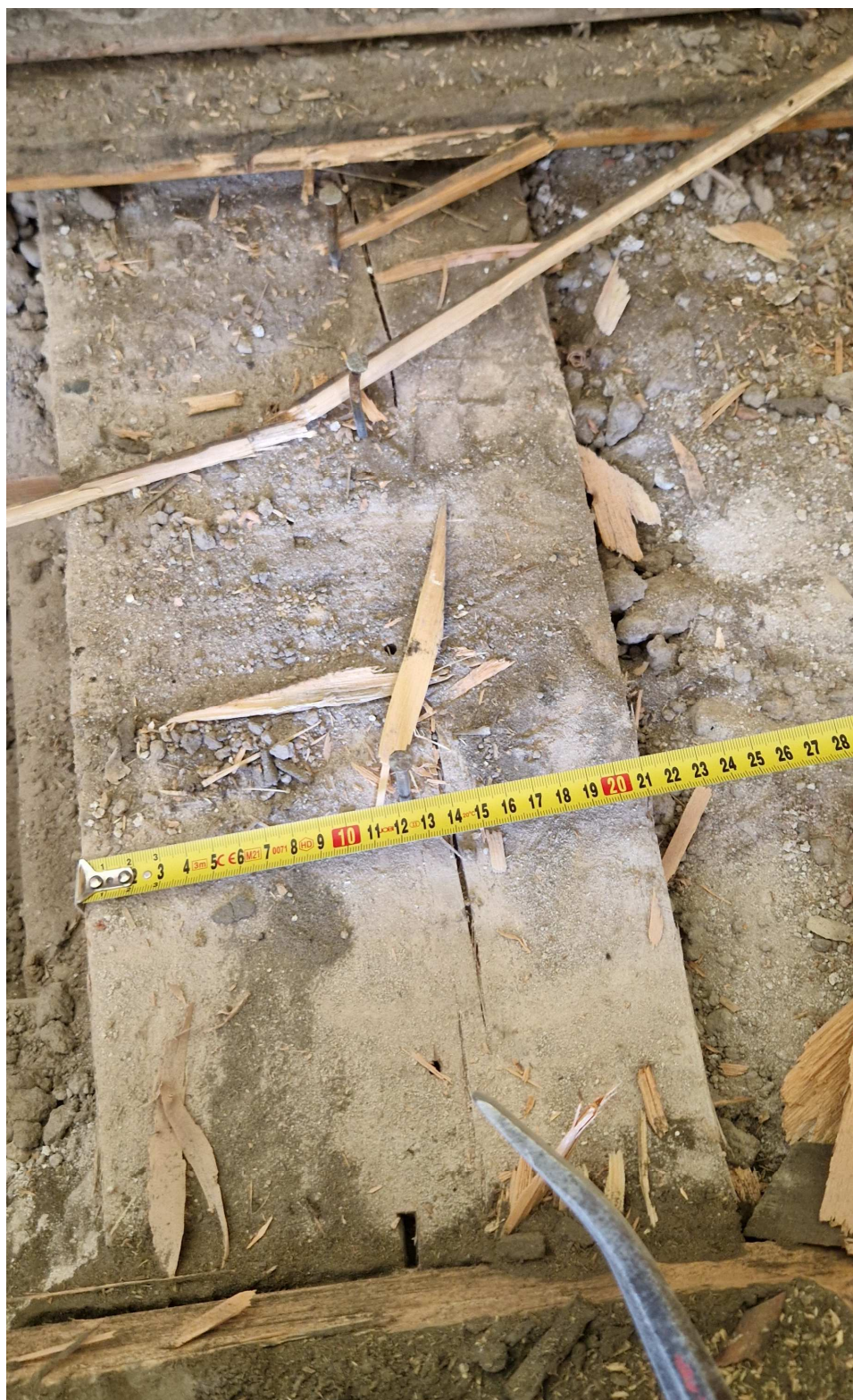
Foto 6. Pomiar szerokości belek nośnych stropu nad parterem.
