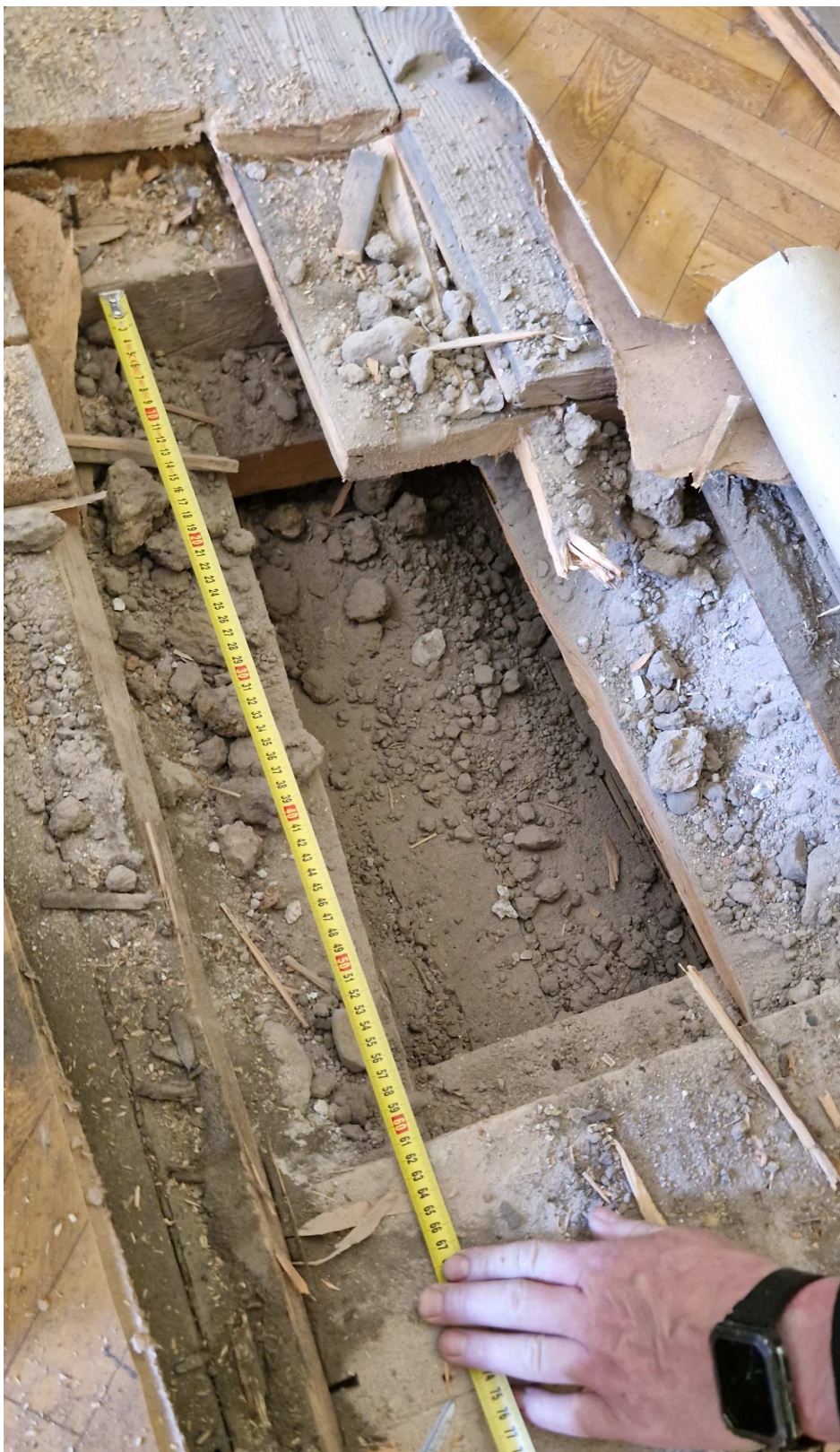
Foto 7. Pomiar rozstawu drewnianych belek stropowych stropu nad parterem..
