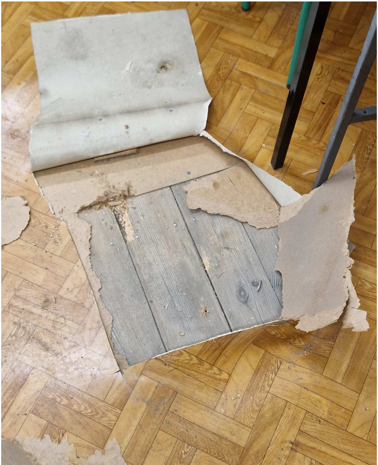
Foto 3. Odkrywka warstw wykończeniowych podłogi nad parterem.
